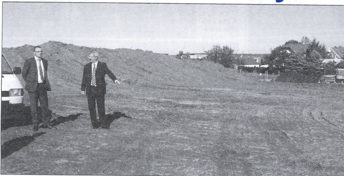
Wójt Waldemar Tkaczyk i zastępca wójta Tomasz Nadolny wizytują rozpoczęcie prac ziemnych pod budowę nowej hali sportowej w Wielkim Klinczu
