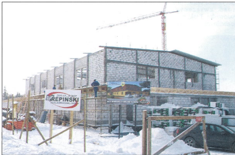
Jedna z największych inwestycji rozpoczętych w 2009 r. - budowa hali sportowej w Wielkim Klinczu
