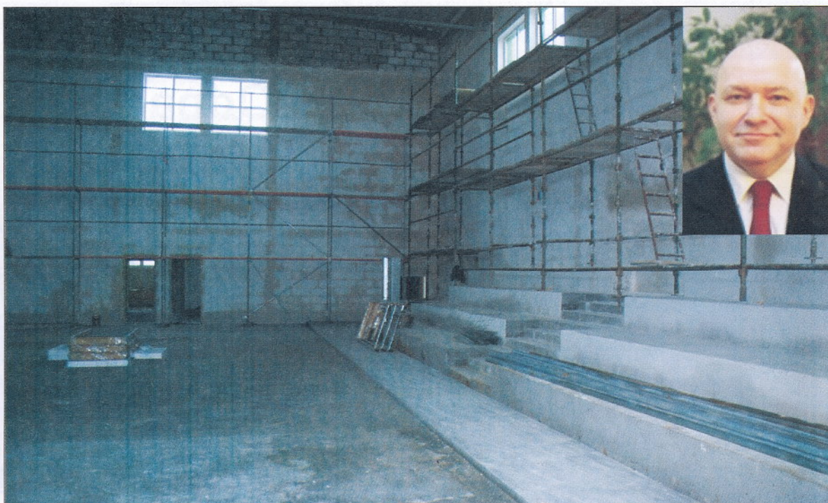
Wicemarszałek Wiesław Byczkowski m. in. wizytował prace na nowo budowanej hali sportowej w Wielkim Klinczu
