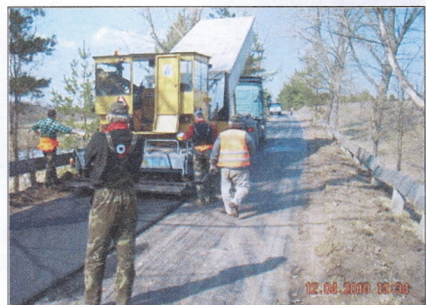
Ułożenie nowej nawierzchni asfaltowej do Czarliny
