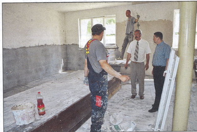
Remont sali wiejskiej i remizy OSP w Nowej Wsi .
