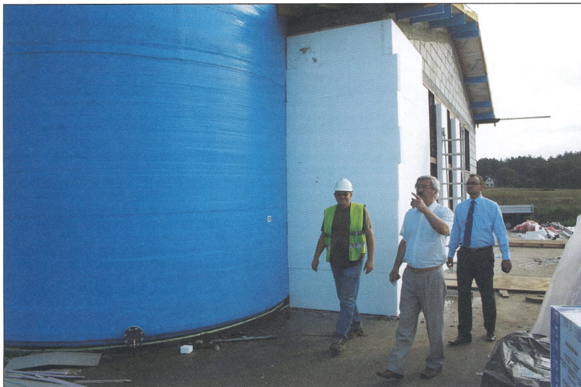
Kolejna z wielkich inwestycji prowadzona przez Gminę Kościerzyna. Rozbudowa i modernizacja Oczyszczalni Ścieków w Wielkim Klinczu, która polega na zwiększeniu przepustowości oczyszczalni z 250m 3 /d do 660m 3 /d a jej koszt wyniesie 7 300 000 zł.
