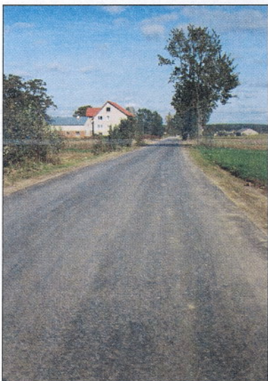
Nowa nawierzchnia na drodze Kościerzyna Wybudowanie -Nowa Wieś.
