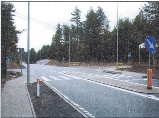
Skrzyżowanie zostało oświetlone, wybudowano chodnik oraz przejście dla pieszych.
