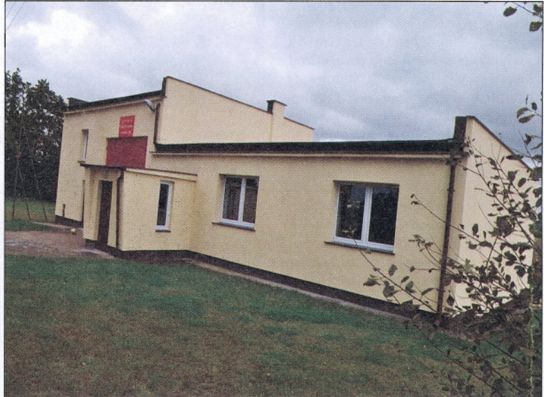
Remiza w Nowej Wsi po gruntownym remoncie.
