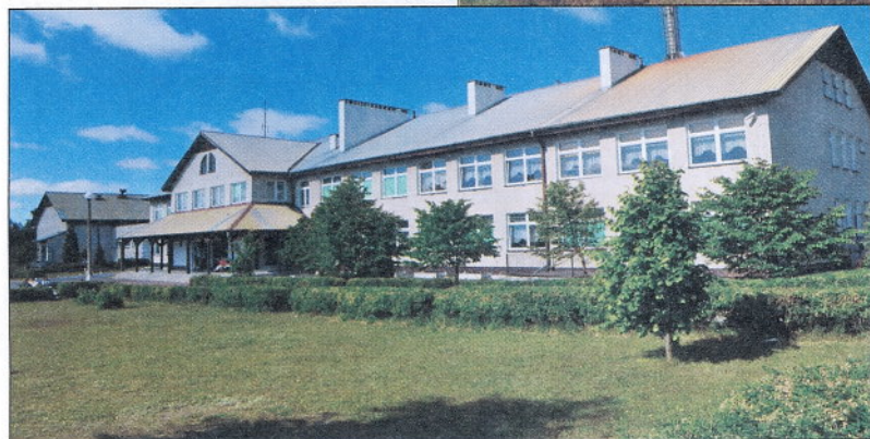
W szkole dokonano rozległego remontu mającego zmniejszyć zużycie ciepła.
