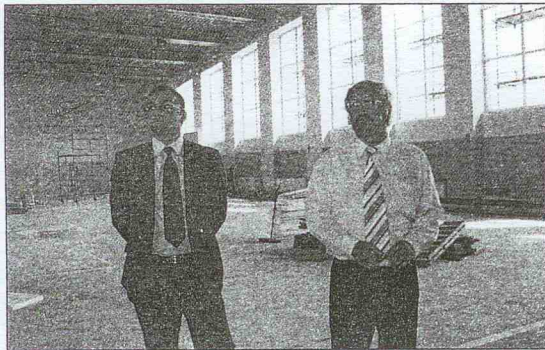
Wójt i jego zastępca wizytują postęp prac remontowych na hali w Skorzewie
