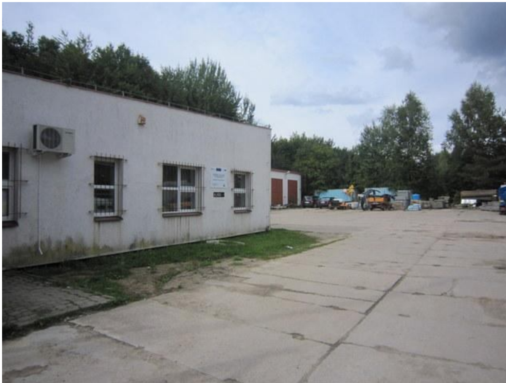
Zakład Komunalny Stare Nadleśnictwo
