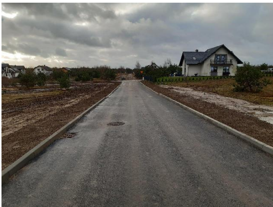
Zmodernizowane drogi w Małym Klinczu
