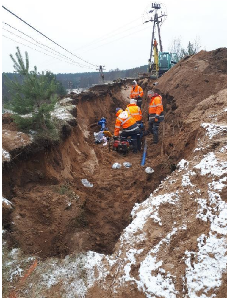
Budowa sieci wodociągowych
