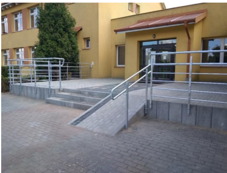
Wyremontowane wejście do przedszkola w Łubianie
