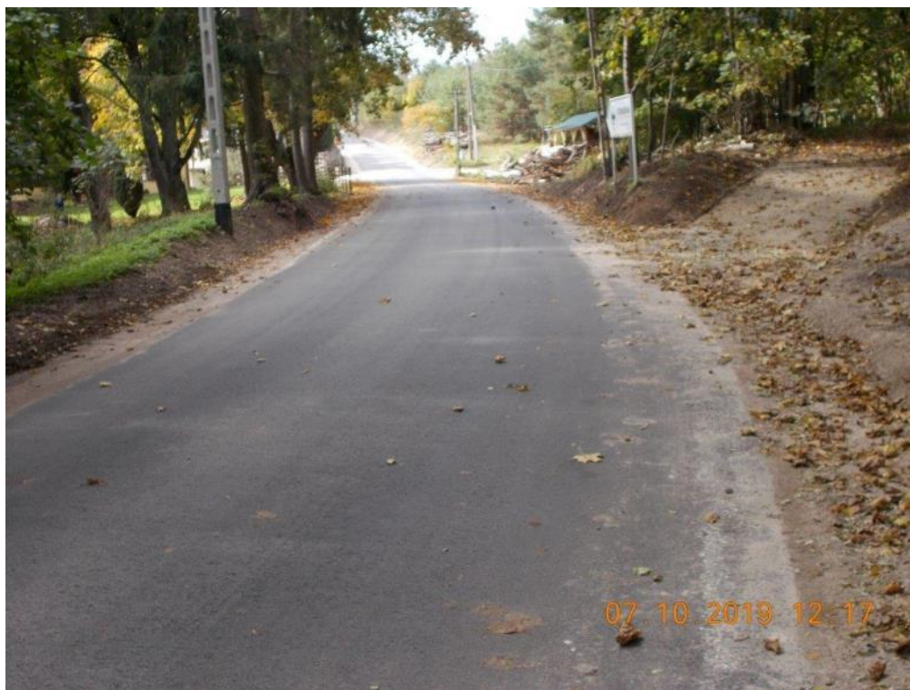
Nowa nawierzchnia asfaltowa w Sycowej Hucie
