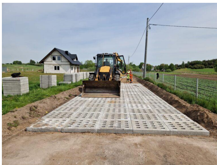
Budowa ul. Łąkowej w Nowym Klinczu
