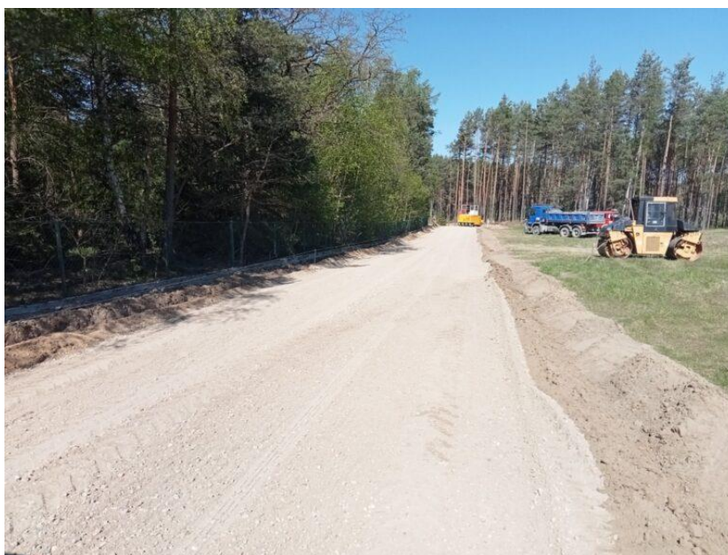
Budowa drogi Łubiana-Grzybowo
