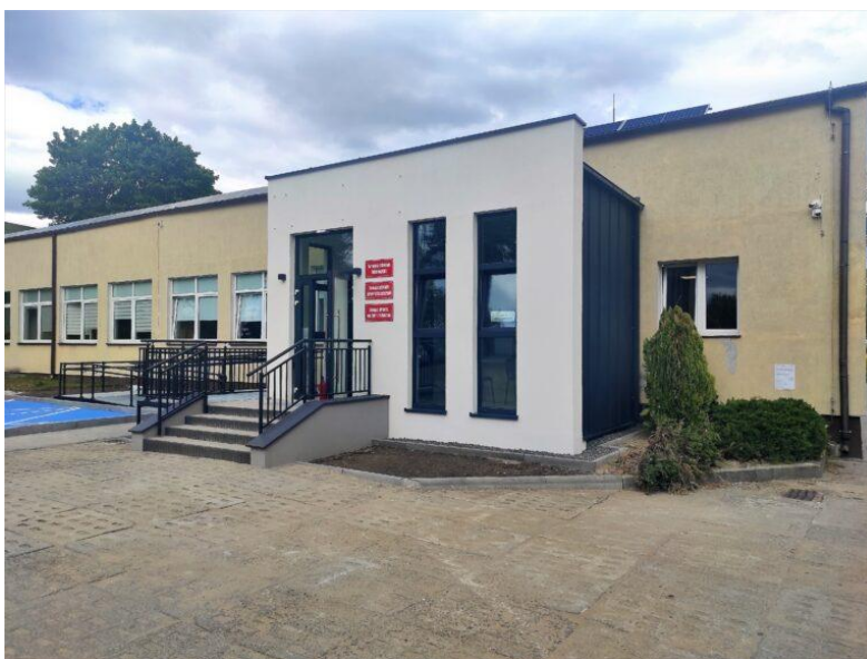
Dostępny samorząd – wejście do urzędu gminy (budynek C) przyjazne osobom niepełnosprawnym
