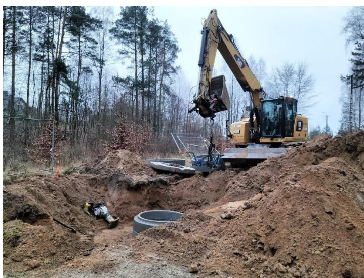
Budowa kanalizacji w Kłobuczynie
