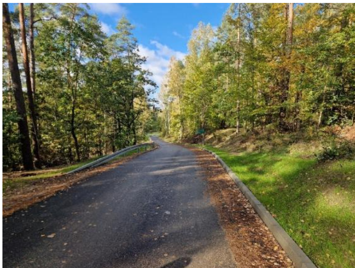
Asfalt na drodze w Wieprznicy
