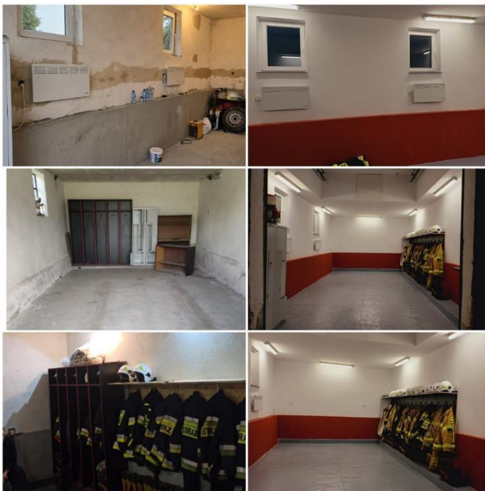
Remont remizy OSP Gostomie
