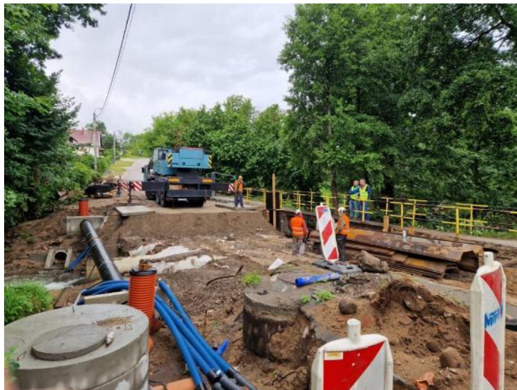
Budowa mostu w Łubianie
