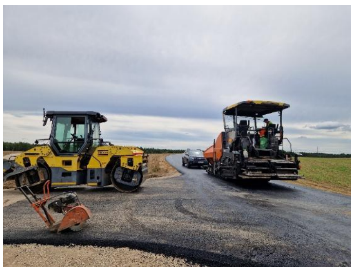
Budowa dróg w Gminie Kościerzyna
