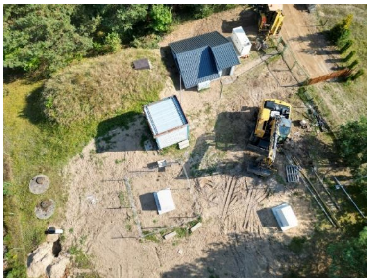
Prace modernizacyjne na ujęciu wody we Wdzydzach
