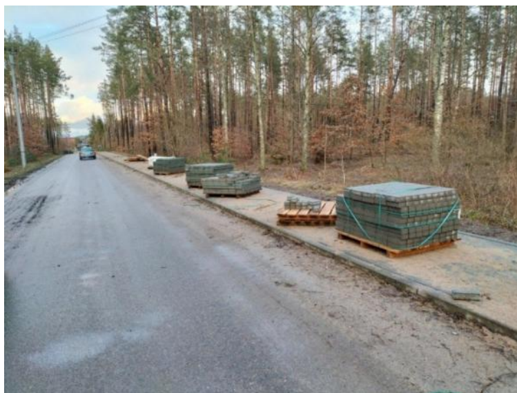
Budowa chodnika w Skorzewie
