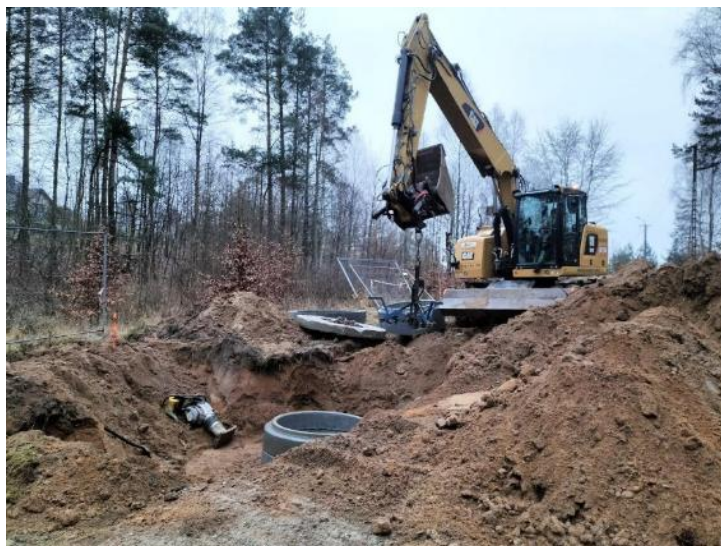
Budowa kanalizacji w Kłobuczynie
