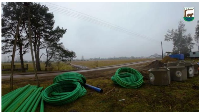
Budowa sieci kanalizacyjnych
